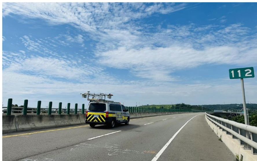
圖 2.2-2 現場作業情形
