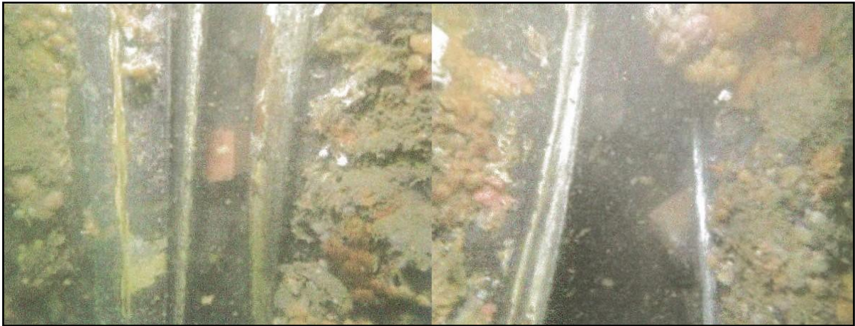
圖 6 鋼板樁裂縫
