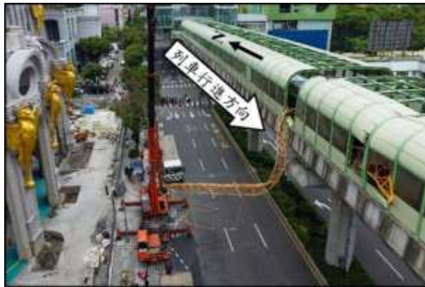
圖 1.1-1 斷裂墜落之桁架侵入捷運路線（本照片由聯合報提供）
