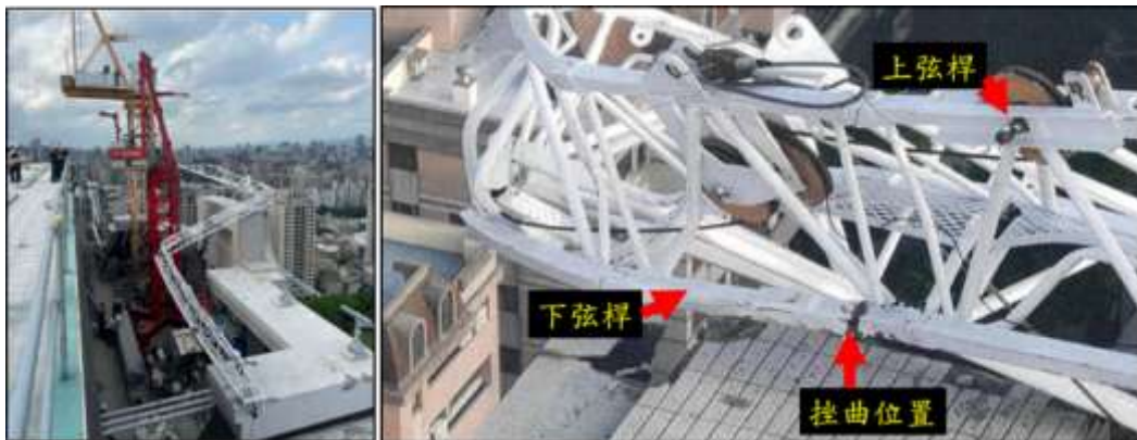
圖 1.3-1 拆除機桁架挫曲情形 6
