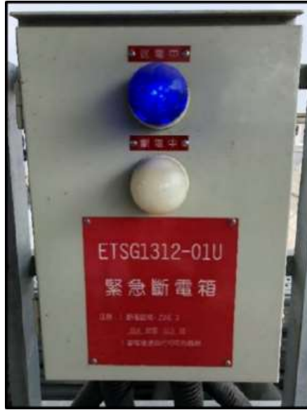
圖 1.9-1 緊急斷電箱（ETS）
