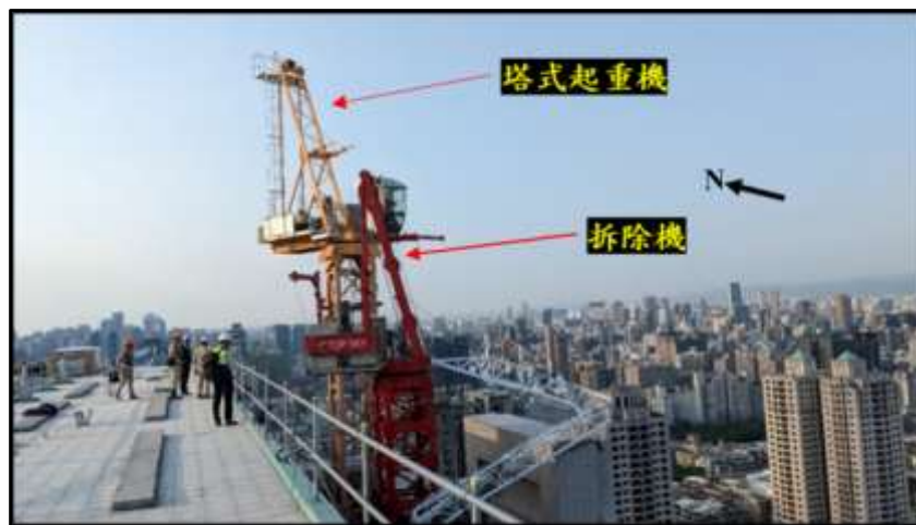
圖 1.1-4 拆除機及塔式起重機相對位置
