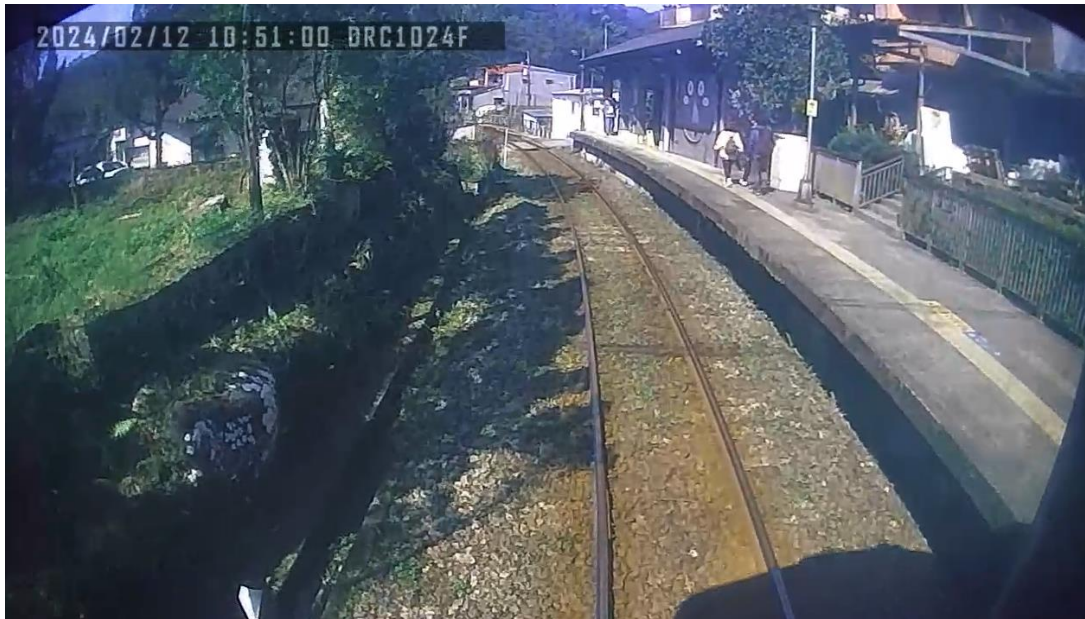
1051:00 時：列車運轉於嶺腳站中段，前方無明顯異物、軌道挫曲及斷軌情形。
