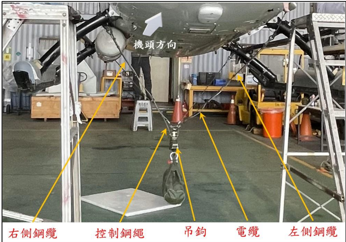
圖 1.6.4-3 吊掛組件安裝實況
