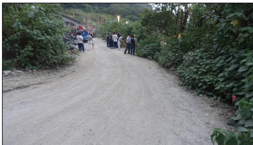
圖 2.1-1 事故發生時施工便道鋪面狀況
