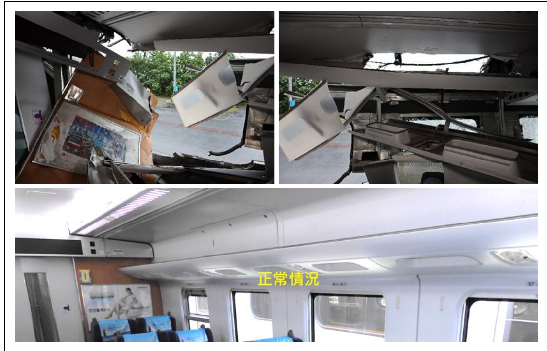
圖 1.13-20 第 7 車後端左側受損情形
