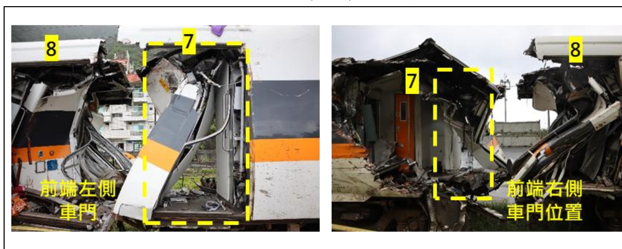
圖 1.13-16 第 7 車前端左、右側車門及玄關通道
