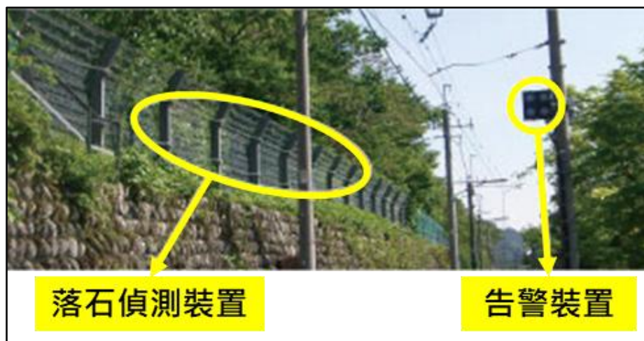
圖 1.7-10 東武鐵道落石偵測告警裝置 15
