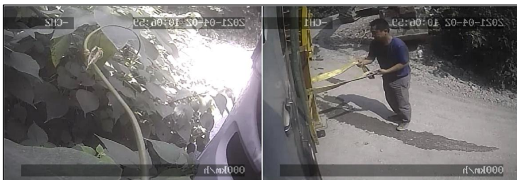
圖 1.10-29 工地主任將吊帶綁上大貨車立柱
