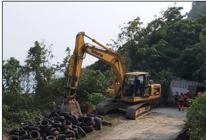
圖 1.8-3 事故挖掘機外觀照片
