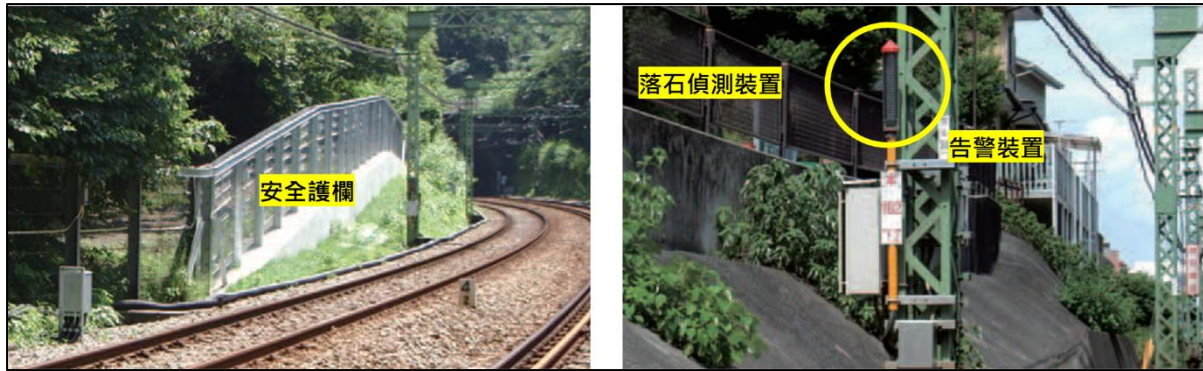
圖 1.7-12 京急電鐵安全護欄及落石偵測裝置 17
