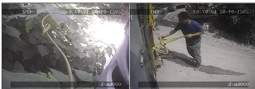
圖 1.10-30 工地主任將吊帶綁上大貨車立柱
