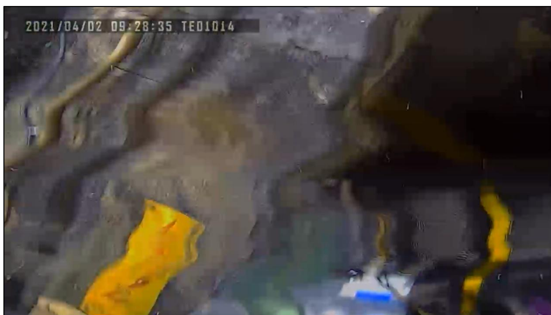
圖 1.10-39 列車撞及清水隧道北口東側
