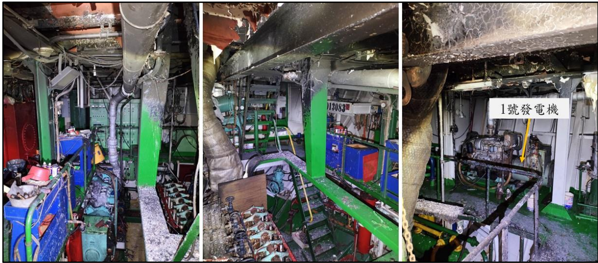
圖 1.4-20 發電機層受損情況
