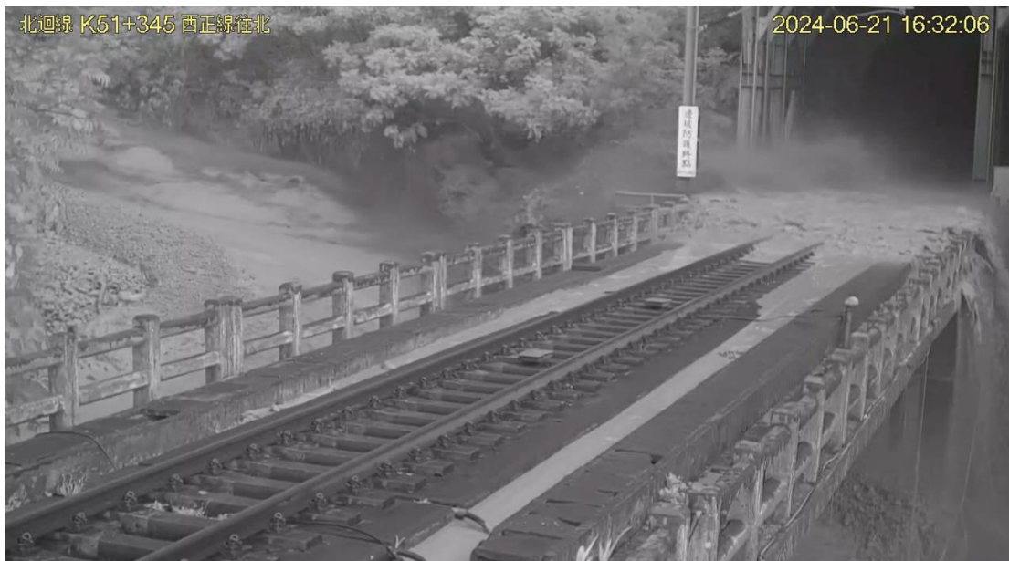
1632:06 時，土石流淹沒軌面。
