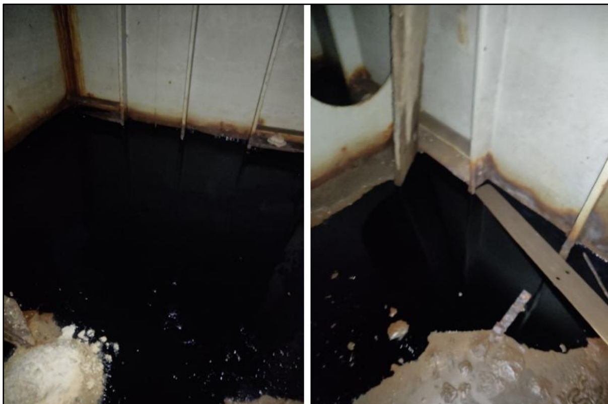
圖 1.1-3 天使輪第 4 貨艙前段燃油洩漏至第 4 貨艙中間走道圖
