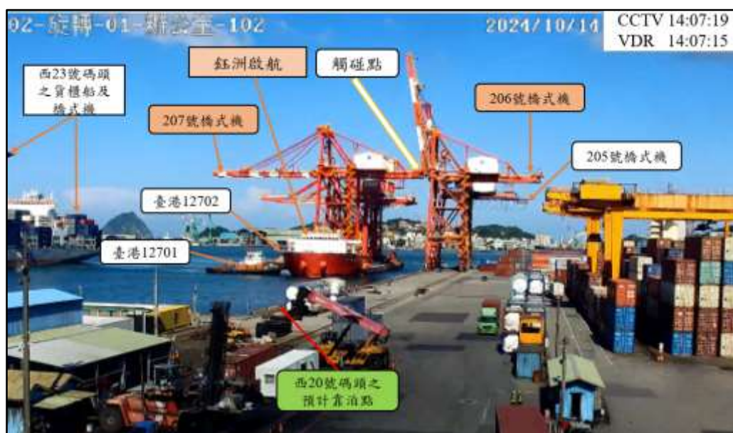
圖 1.1-2 2 部橋式機觸碰期間港區監視系統影像截圖
