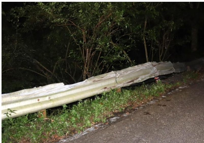
圖 1.4-1 對向車道護欄損害情況
