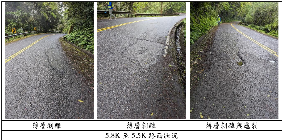
圖 1.8-4 事故路段路面破壞狀況
