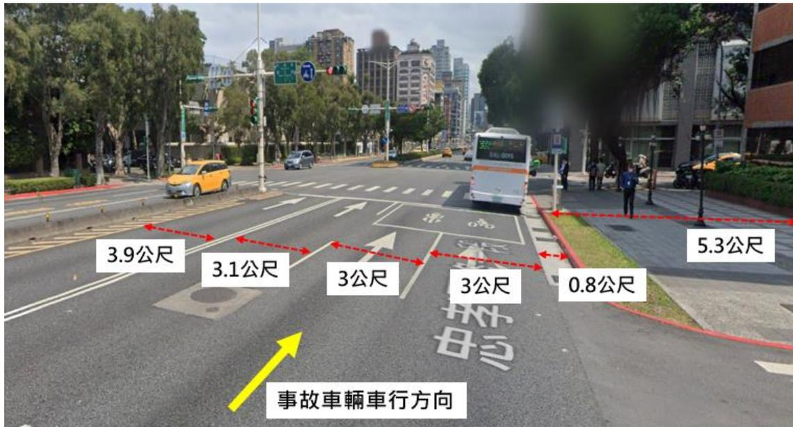
圖 1.8-2 忠孝東路一段橫斷面車道寬度現場量測資料
