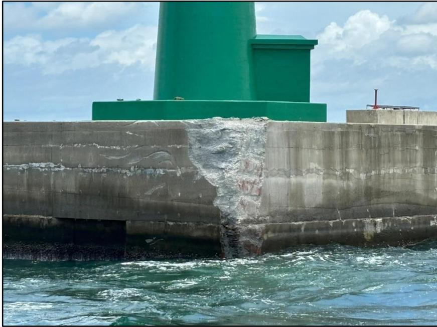
圖 1.3-4 離岸堤受損照片
