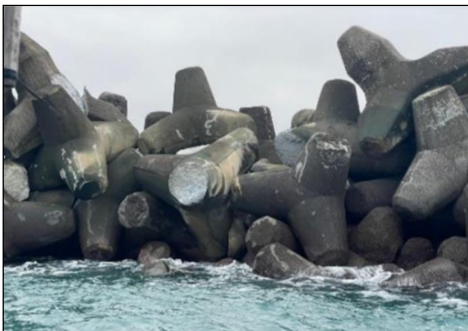
圖 1.3-3 營明輪擱淺地點之西防波堤消波塊照片
