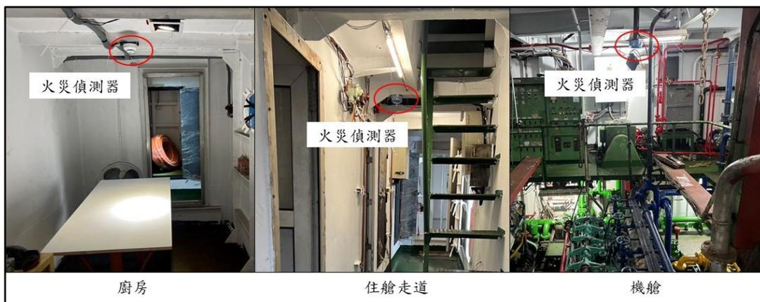
圖 4.1-1 火災偵測器照片
