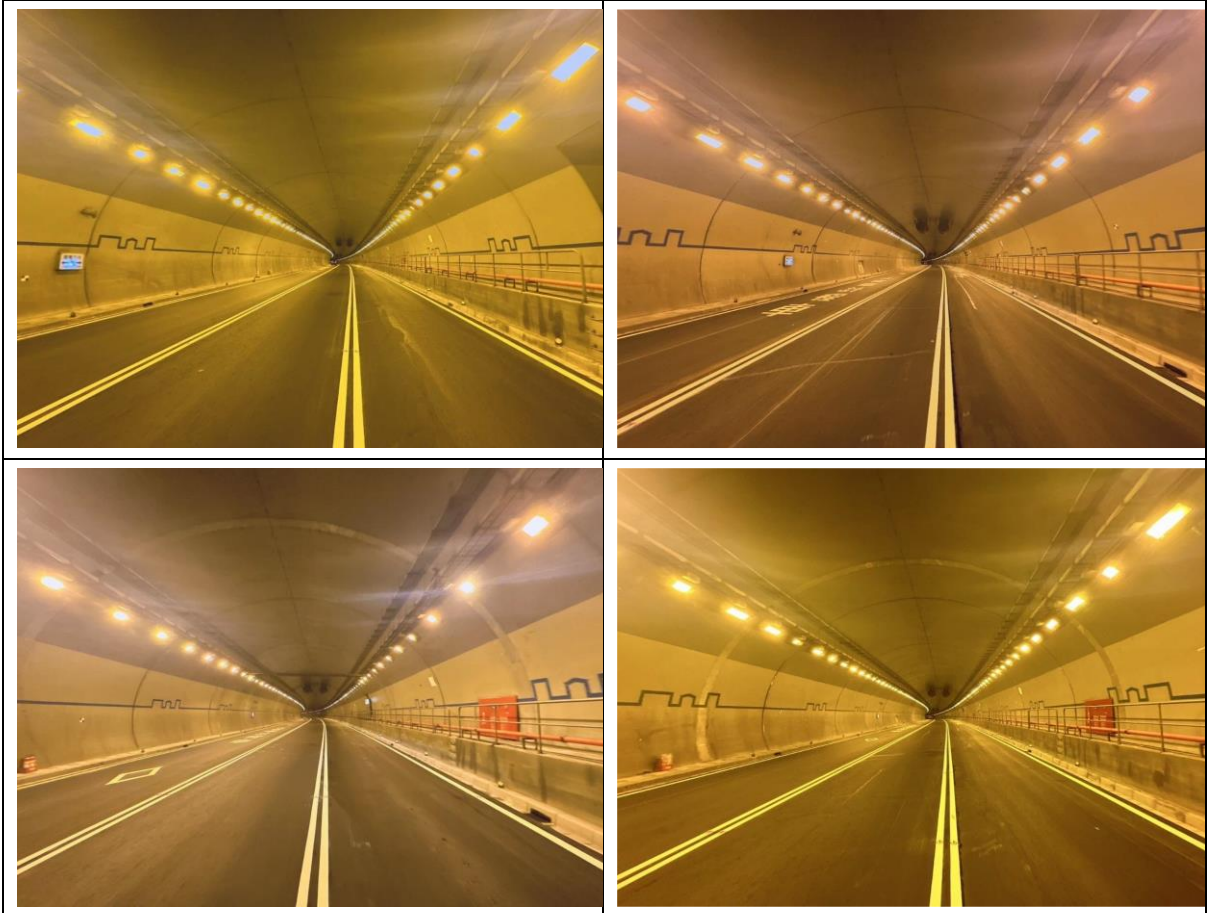
鋪面改善後（瀝青混凝土銑刨加鋪，拍攝日期為民國 113 年 7 月 5 日）
