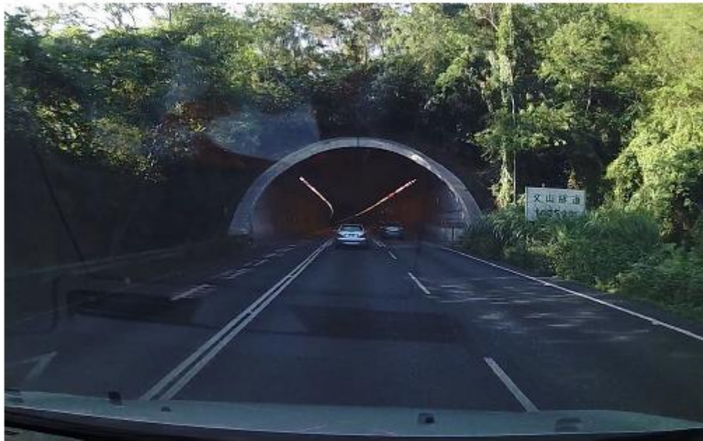
圖 1.2-2 現場作業情形
