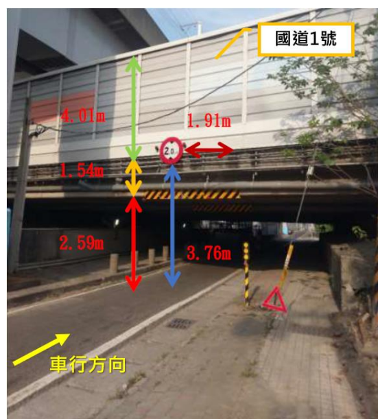
圖 1.8-1 事故地點涵洞高度測量結果圖 12
