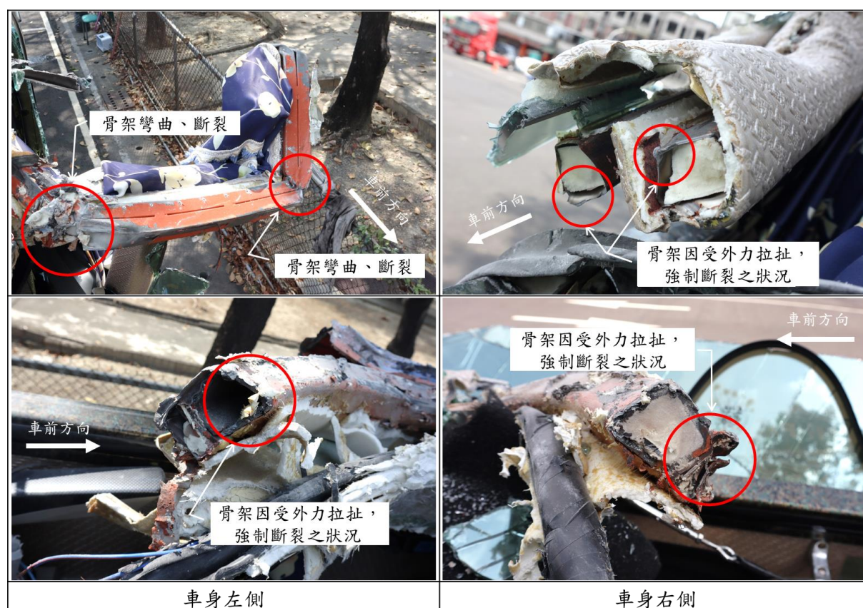
圖 2.3-1 車體骨架損害情況
