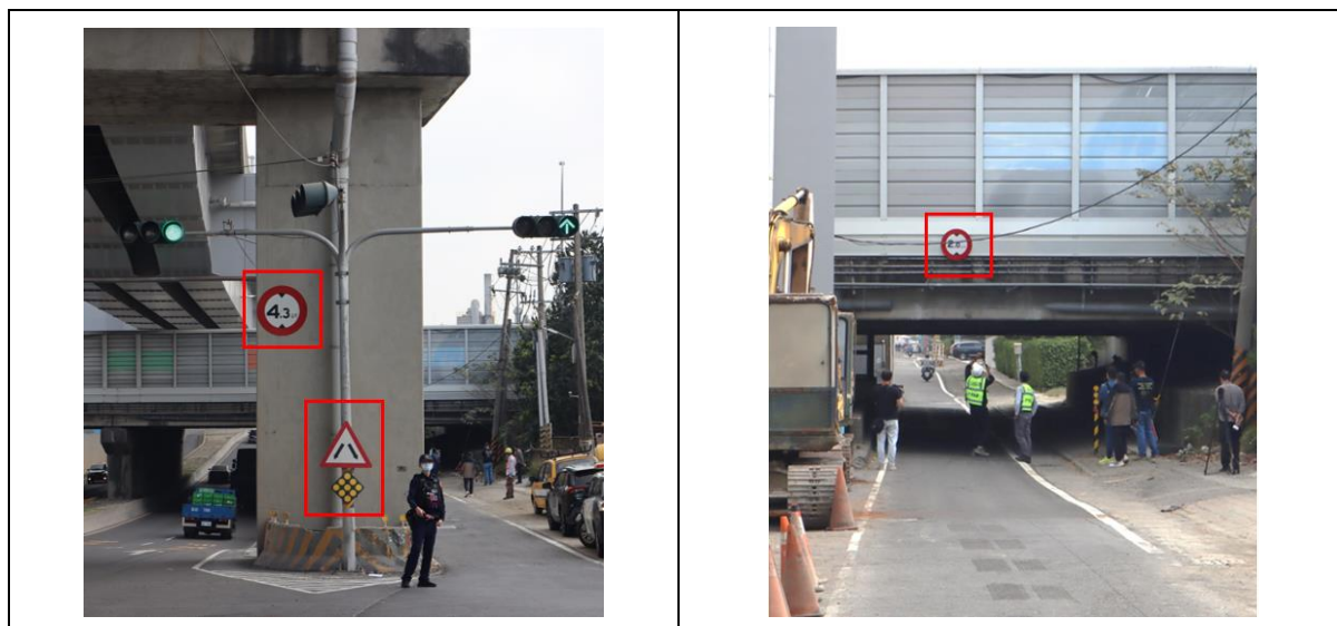
圖 2.2-1 事故路段標誌設置情形
