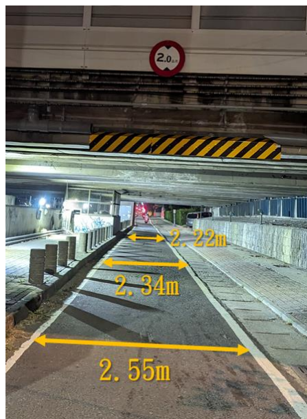
圖 1.8-2 事故地點涵洞下方慢車道寬度測量結果圖
