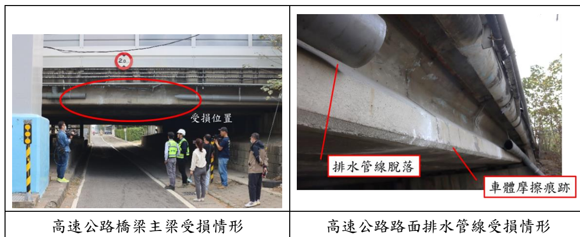
圖 1.4-1 道路設施受損情形
