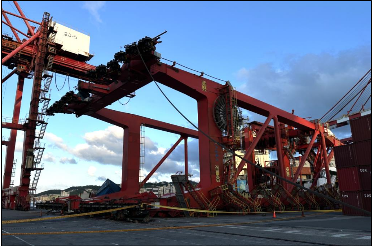
圖 1.1-5 206 號橋式機倒塌至西 19 號碼頭外觀圖
