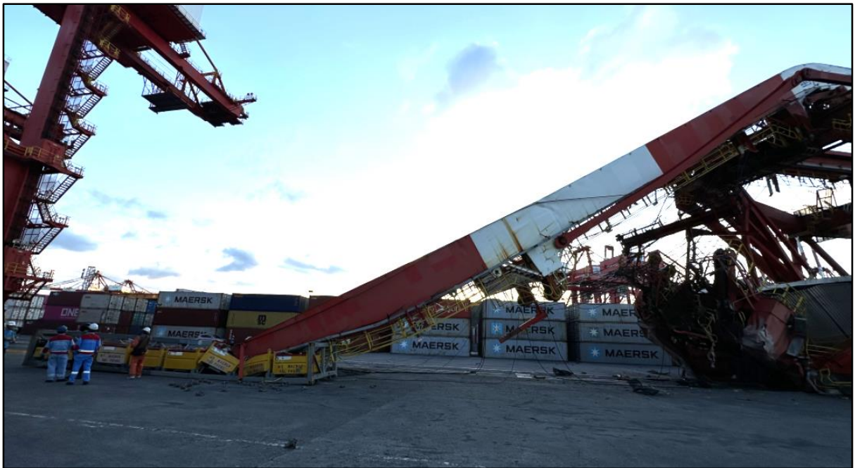
圖 1.4-2 206 號橋式機及數個貨櫃鎖具箱子受損外觀圖
