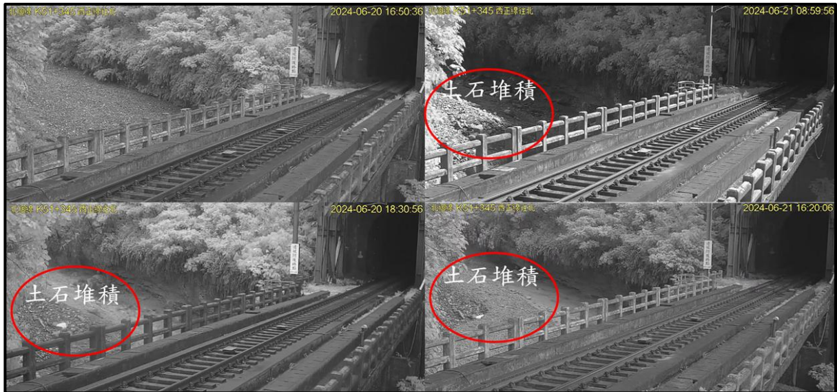
圖 2.1-3 大清水溪河道土石堆積圖
