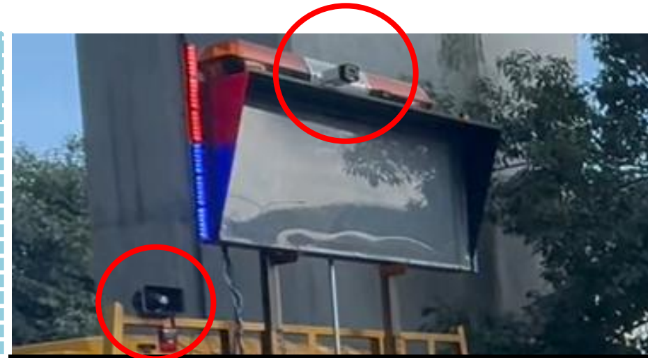
攝影機裝設於LED顯示板上指向性蜂鳴器裝設於車頂
