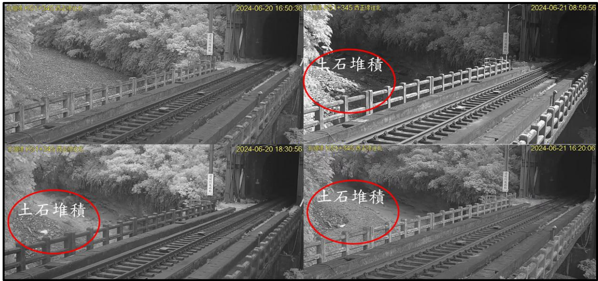
圖 2.1-3 大清水溪河道土石堆積圖
