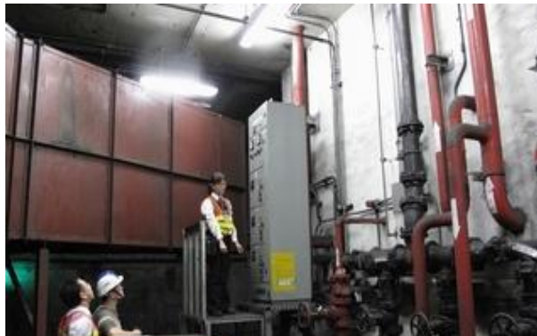
排水設施控制盤位置提高
