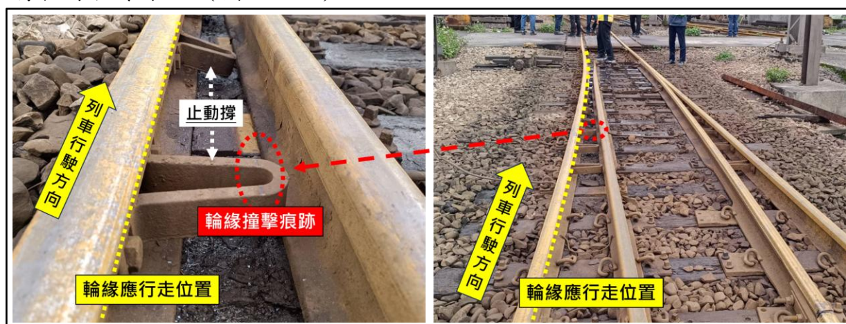
圖 1.10-1 第 509 號道岔左軌處輪緣撞擊痕跡
