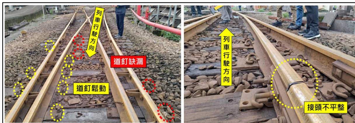
圖 1.10-3 第 509 號道岔道釘鬆動缺漏及魚尾鈑接頭處不平整
