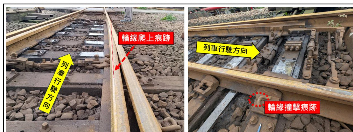
圖 1.10-2 第 509 號道岔右軌處輪緣爬上痕跡及輪緣撞擊痕跡
