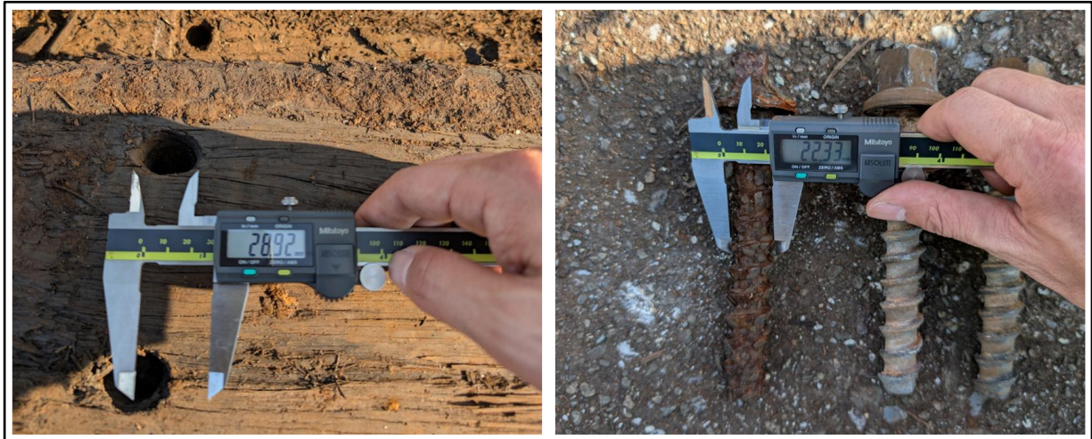
圖 1.10-7 第 509 號道岔枕木道釘孔洞擴大
