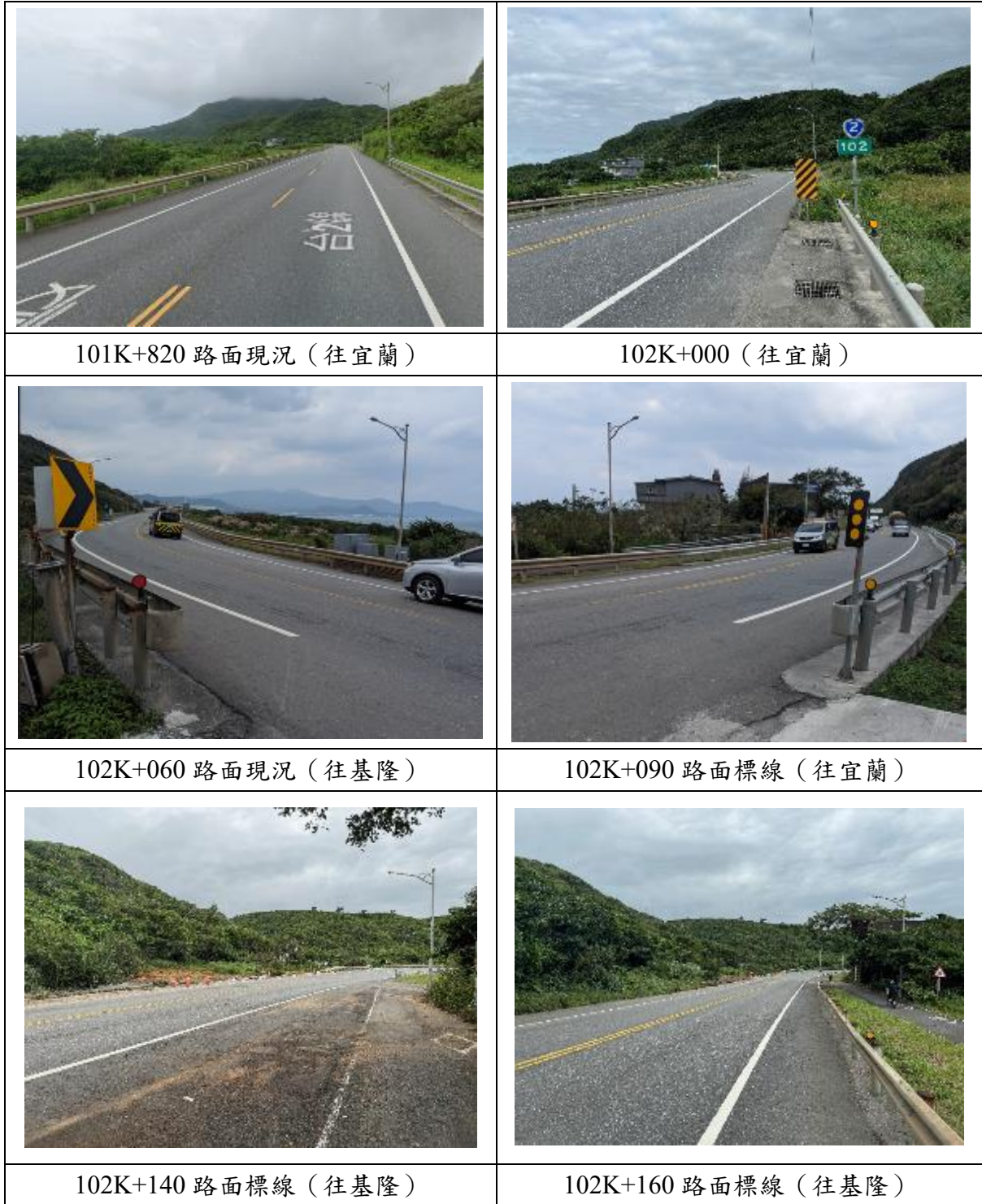
圖 1.8-3 事故路段路面狀況及標誌標線設置位置圖
