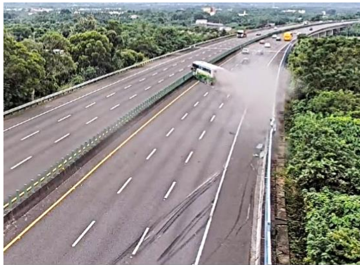
事故大客車車頭撞擊內側護欄
