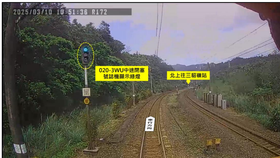
圖 1.9-3 西正線北上中途閉塞號誌機 020-3WU 顯示號誌
