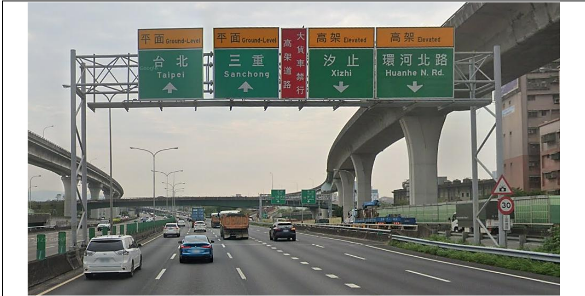
國 1 北向平面 33.3K 門架式方向、車道指示標誌、告示牌及車道配置
