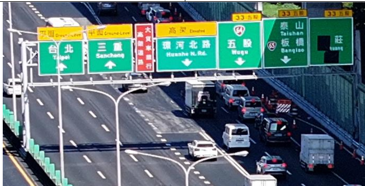
國 1 北向平面 33.7K 門架式方向、車道指示標誌、告示牌及車道配置
