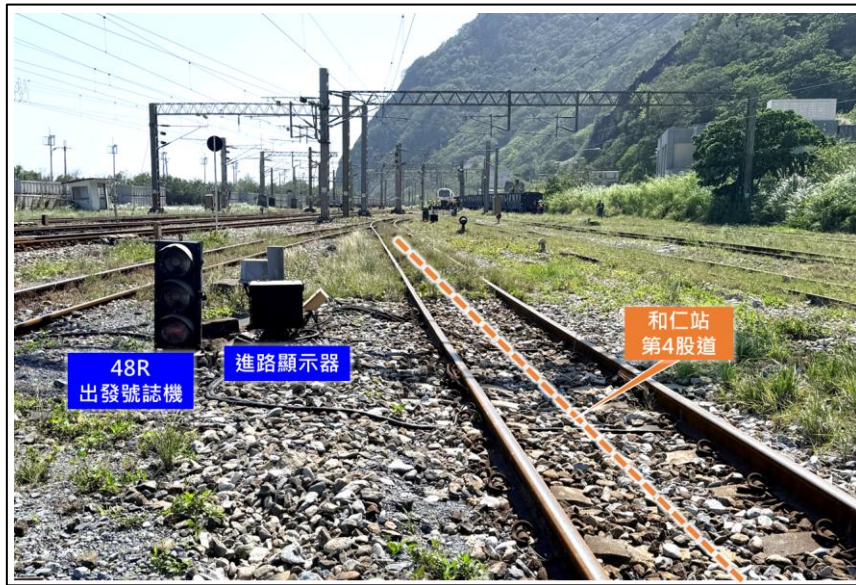
圖 1.6-4 和仁站第 4 股道下行第 48R 出發號誌機及進路顯示器
