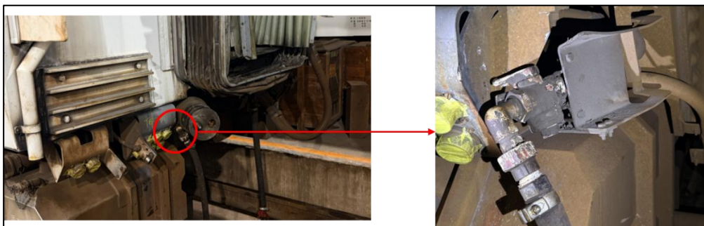
圖 3 第 6 車廂主儲氣槽考克及固定座毀損
