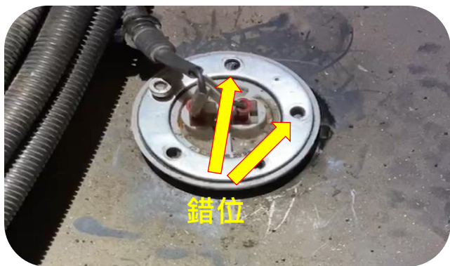
浮筒固定座螺絲孔有錯位情形 浮筒不鏽鋼固定座板片歪斜
